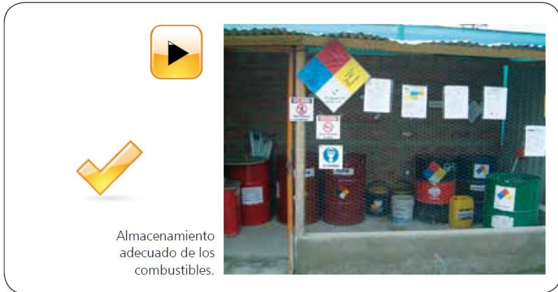
Figura 13. Manejo adecuado del almacenamiento de materiales en la obra.
