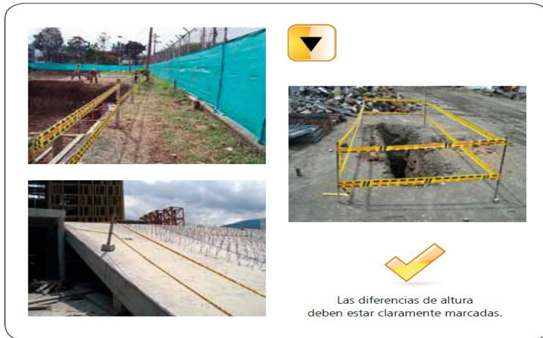
Figura 30. Manejo adecuado de la señalización
